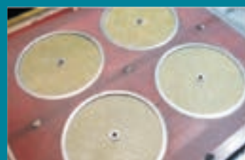
Розміщення другого шару сітки зі скловолокна
